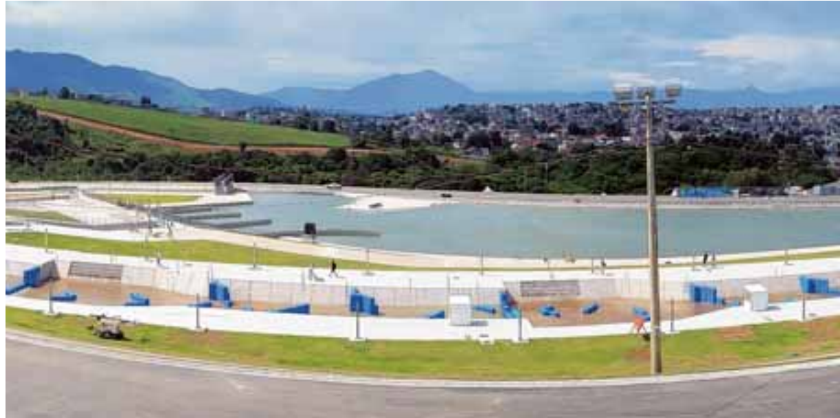
Die künstliche Slalomstrecke in Brasilien ohne Wasser. Die blauen Plastikhindernisse sollen dem Kanal den Wildwassercharakter geben.
